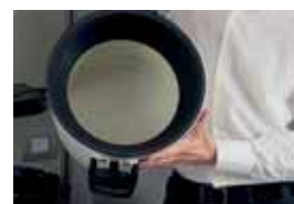
Staubbehälter Absaugzentrale
